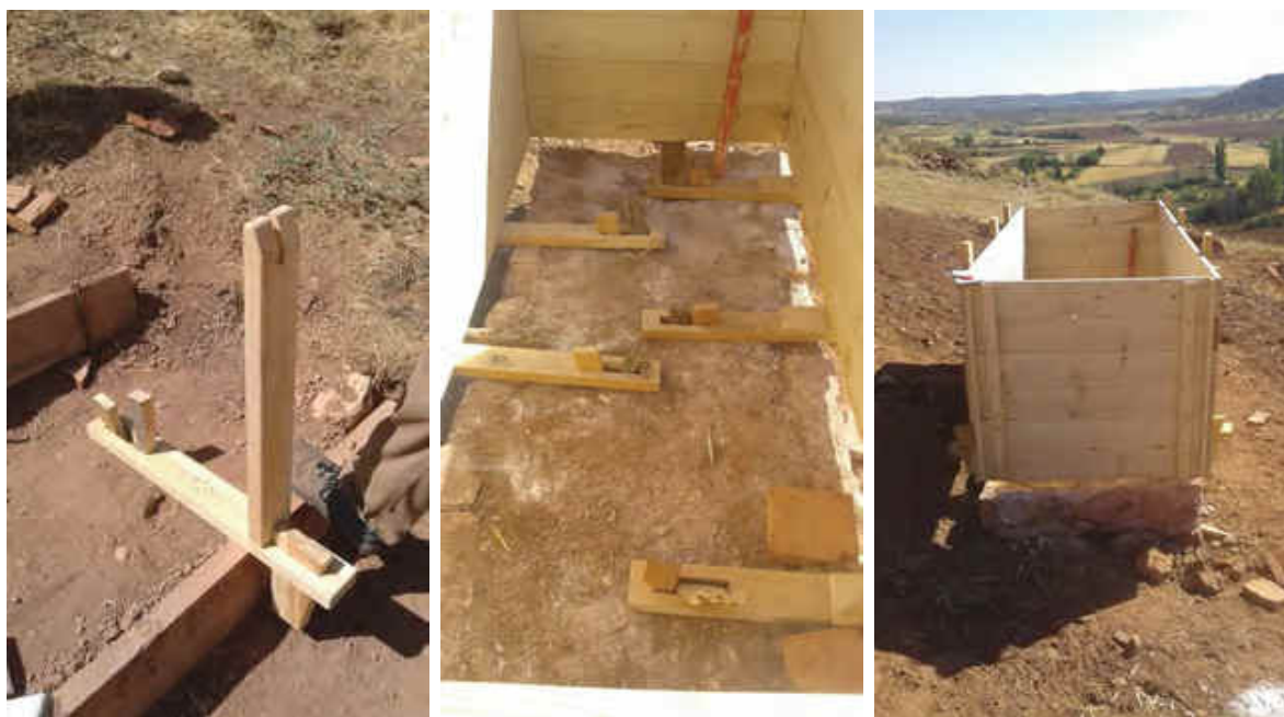
Figura 17. Distintas fases de la colocación del montaje del tapial y sus elementos: a) sujeción de aguja con clavo de madera y del costero con cuña en la aguja, b) colocación del tapial sobre las agujas, c) acodalado y atado del conjunto (fuente: F. Castilla)
