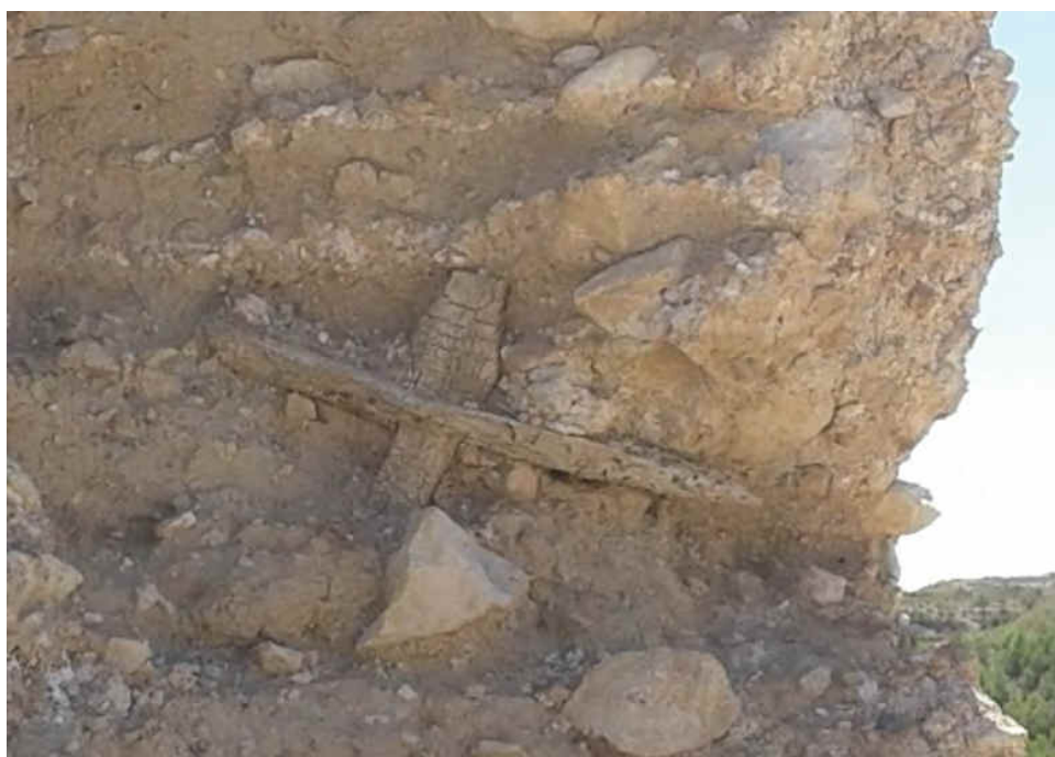
Figura 11. Aguja con clava de madera en el interior de un lienzo de la muralla de Jorquera (Albacete) (fuente: F. Castilla)
