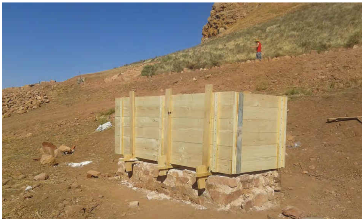
Figura 14. Tapial montado sobre el zócalo de mampostería y relleno de canto y tierra compactada (fuente: F. Castilla)
