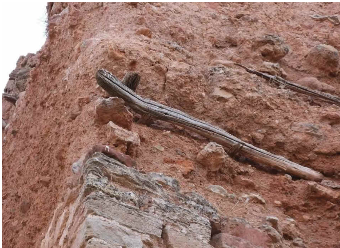
Figura 9. Rollizos de madera de sabina embutidos en el muro (fuente: F. Castilla)
