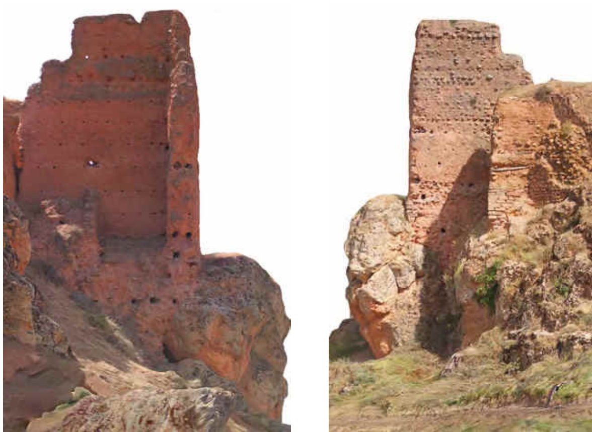
Figura 4. Fotogrametría del muro Noroeste de la torre del Gallo. Interior (izquierda) y exterior (derecha) (fuente: D. Gallego)
